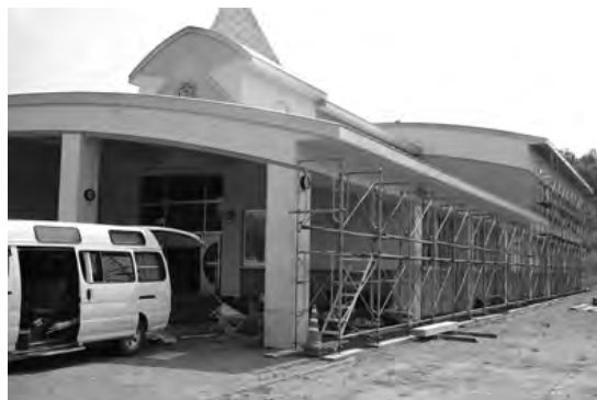
宿泊施設の改修工事が進む「そうや自然学校」
