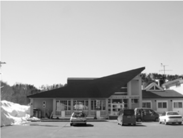
懸案のピンネシリ温泉外壁改修工事に着手！
