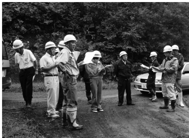
必要な公共工事か!? 基幹作業道松音知1号線開設工事調査
