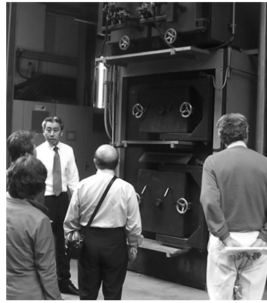
温泉ボイラー、燃料は木質バイオマス
