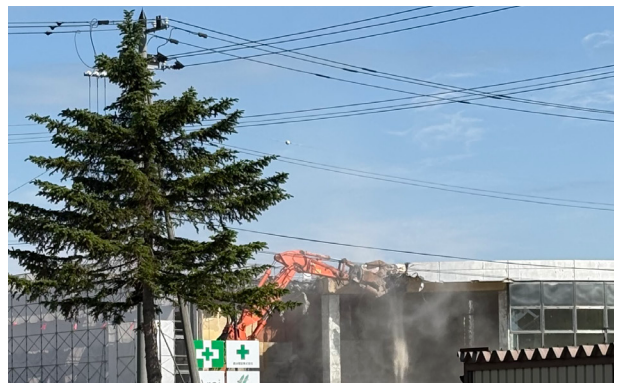
中頓別小学校改修工事の様子
